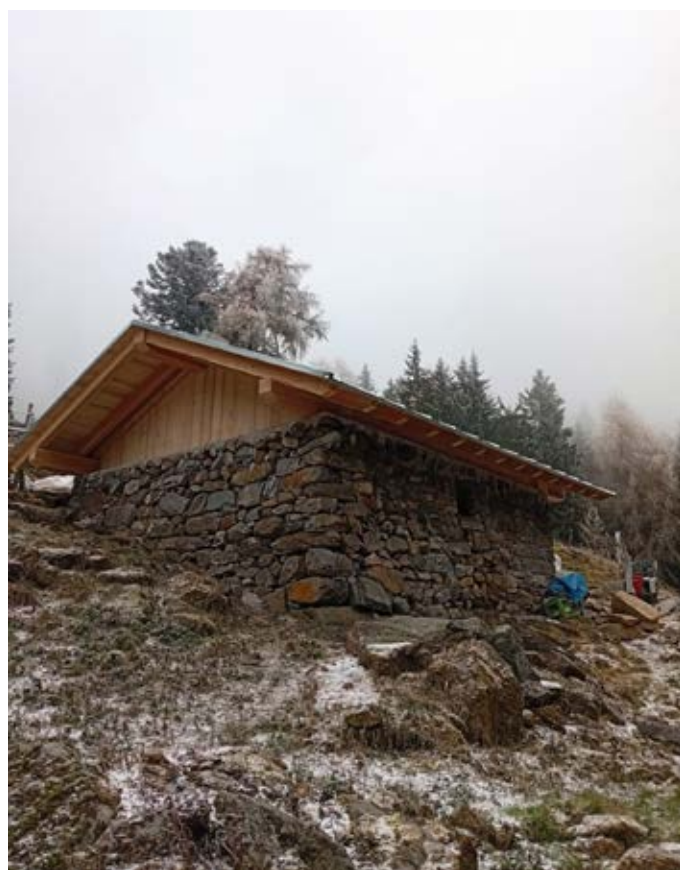
Ristrutturazione casina malga Nagrè (anno 2025-26)
