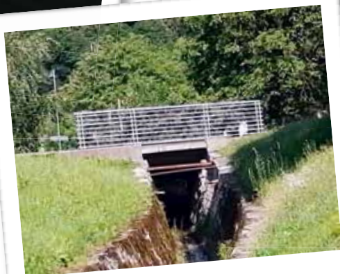
Nuovo parapetto sul ponte del rio "Dugal" a Mortaso
