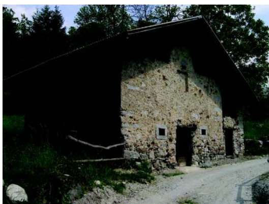
Fig. 7a: Finitura esterna in malta calce spenta
