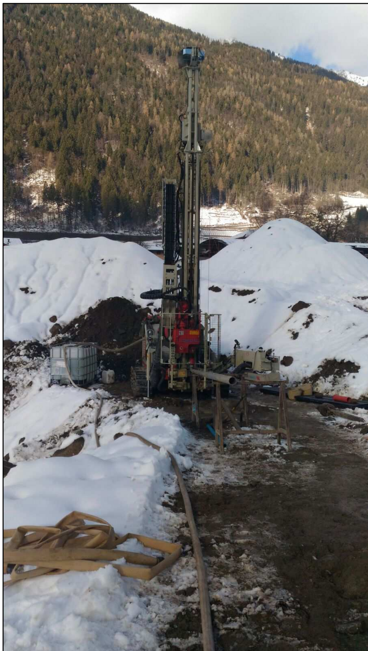
Posizionamento della sonda per l'esecuzione del sondaggio n.3 e messa in opera del piezometro
