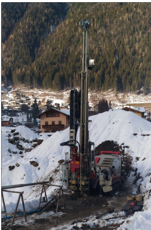
Piazzamento perforatrice su sondaggio S3
