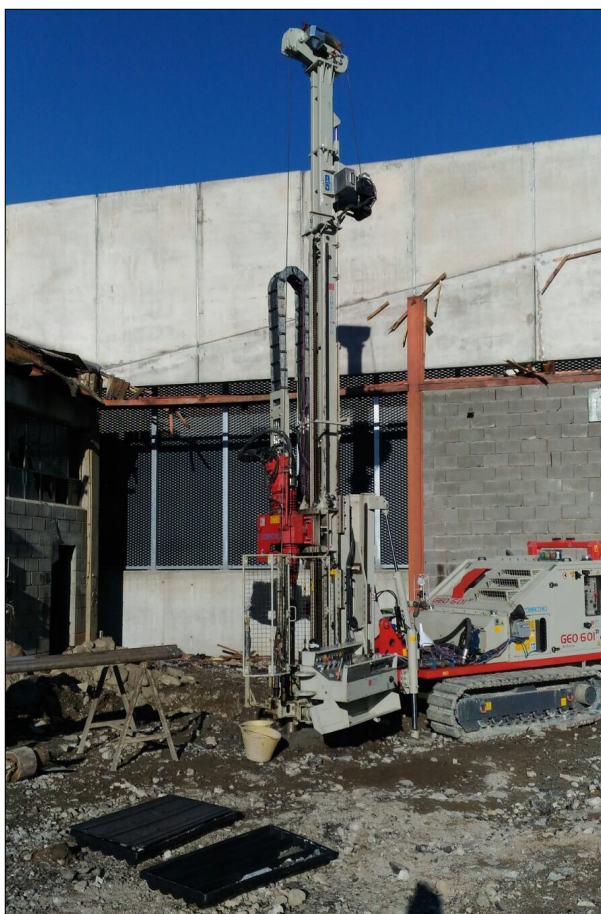
Piazzamento perforatrice su sondaggio S2
