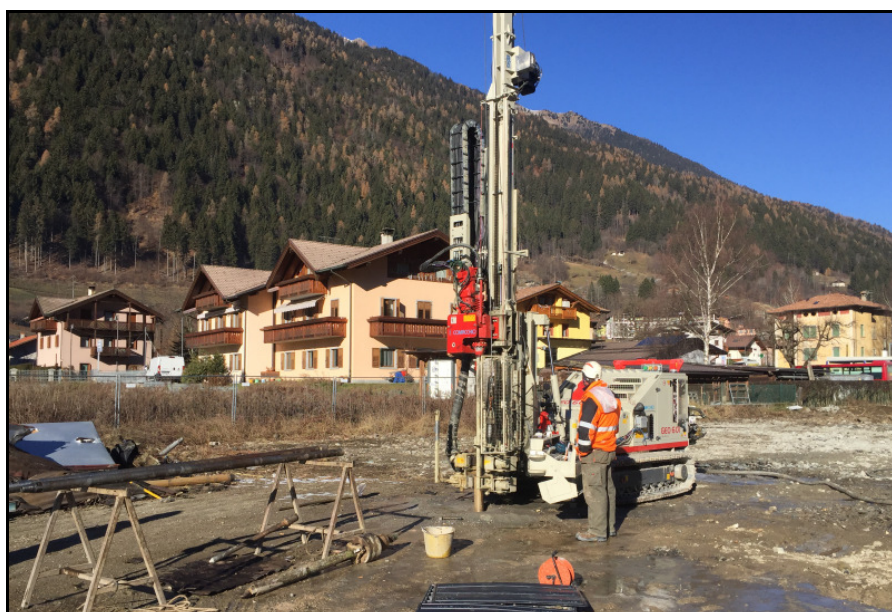
Figura 1- Piazzamento della perforatrice Comacchio GEO601 (punto S1).
