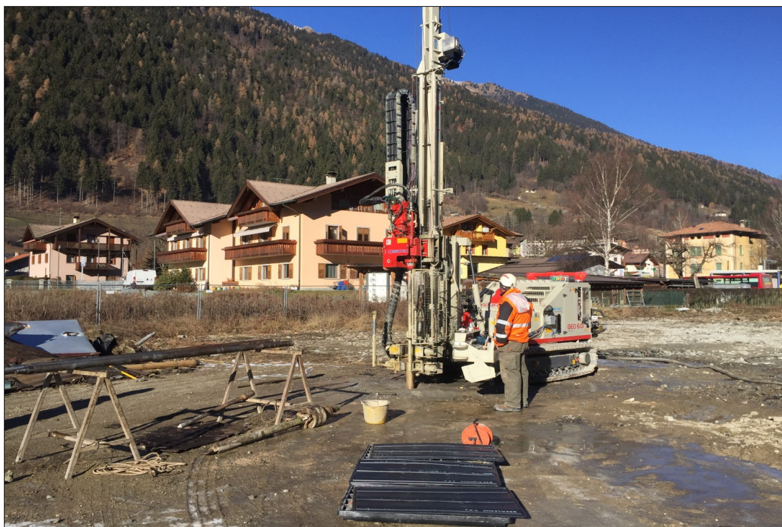
Piazzamento perforatrice su sondaggio S1
