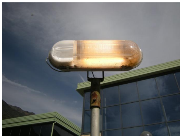
Figura 29: Particolare proiettore con lampada a sodio bassa pressione
