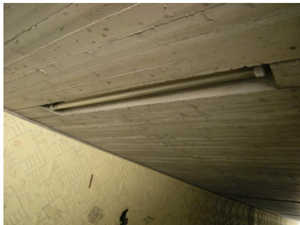
Figura 31: lampada fluorescente illuminazione sottopasso
