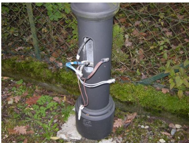
Figura 16: Giunzioni linee IP mediante il solo utilizzo di morsetti volanti
