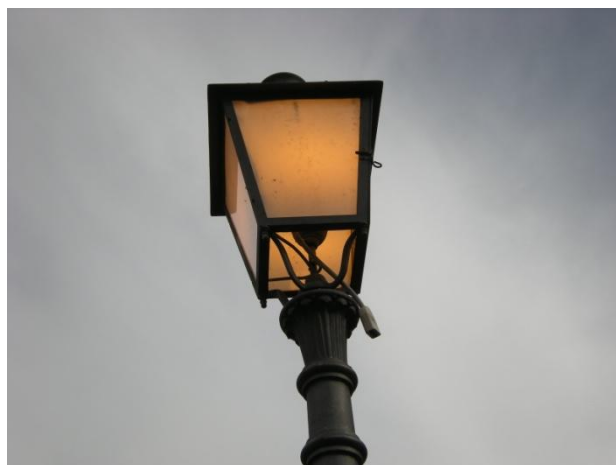
Figura 23: Particolare presa di corrente "volante" non protetta.
