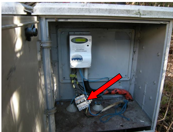
Figura 14: Collegamenti linee Ip al punto di consegna quadro Borzago.
