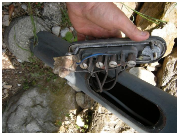
Figura 17: Apparecchiature con grado di protezione <IP20
