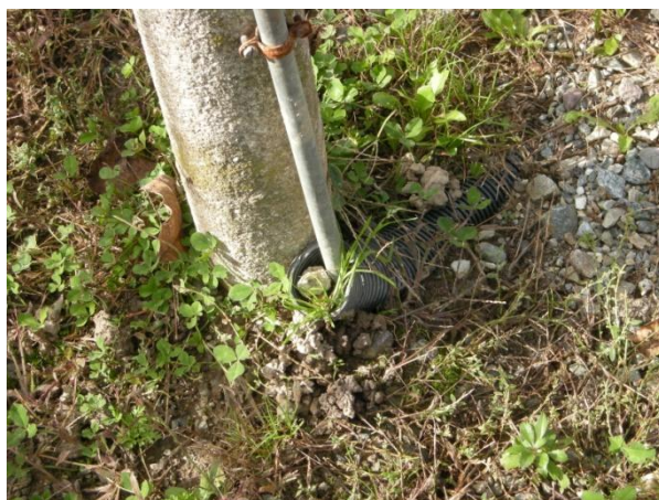
Figura 25: Particolare uscita cavo elettrico da cavidotto non protetto meccanicamente.
