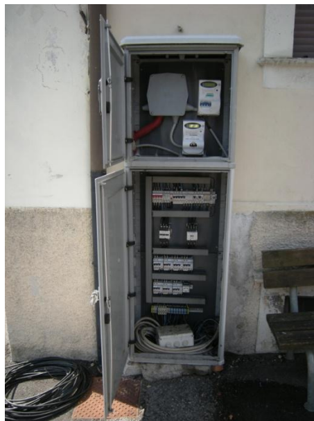
Figura 3: Quadro elettrico illuminazione pubblica presso ex Municipio (Q.SPIAZZO 2).
