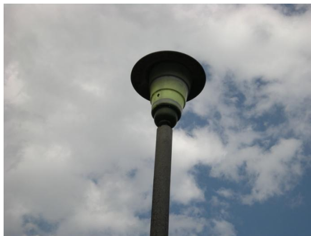
Figura 21: Particolare attacco a testa palo con distacco parziale della lampada.
