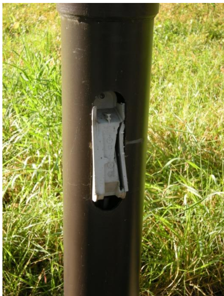
Figura 12: Morsettiera priva di coperchio lungo via Liciola a Borzago.
