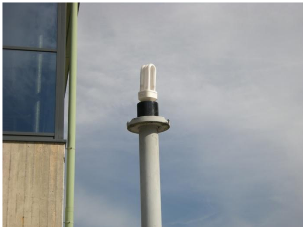
Figura 26: Particolare corpo illuminante privo di protezione.
