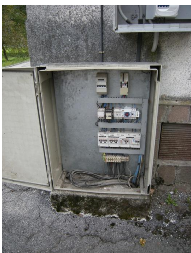
Figura 4: Quadro elettrico illuminazione pubblica in frazione Fisto via Da O (Q.FISTO 1).
