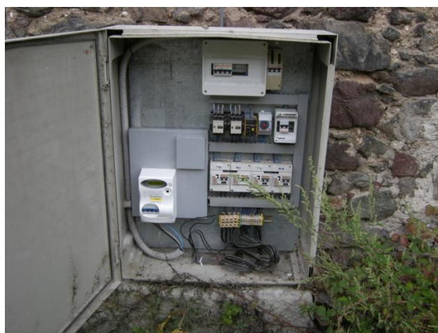
Figura 5: Quadro elettrico illuminazione pubblica in frazione Fisto (Q.FISTO 2).
