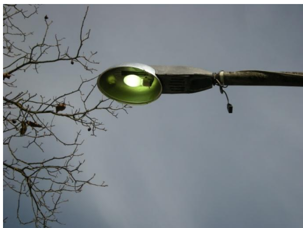
Figura 24: Particolare presa di corrente "volante" non protetta.
