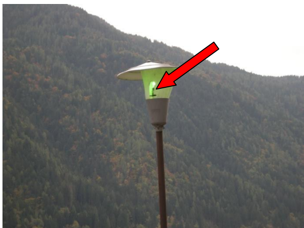
Figura 28: Particolare corpo illuminante con schermo rotto
