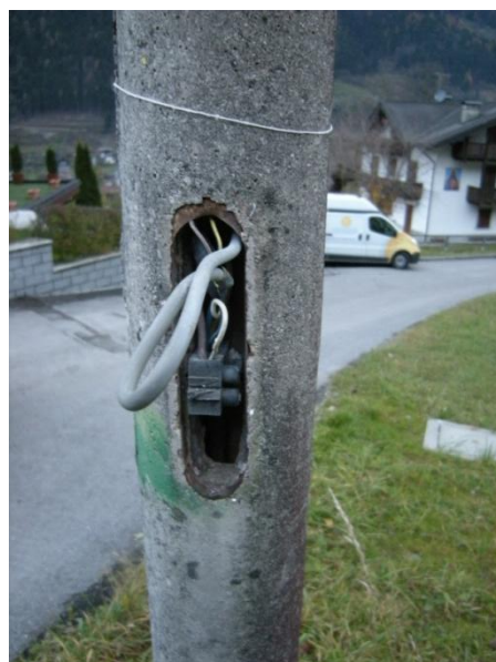
Figura 19: Giunzioni linee IP mediante l'utilizzo di morsetti tipo "mamut"
