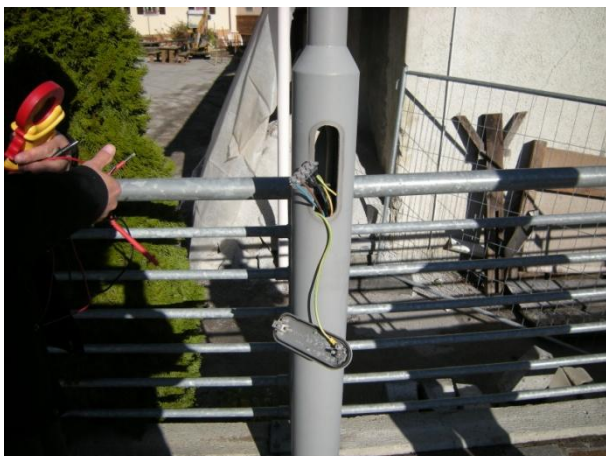
Figura 16: Giunzioni linee IP mediante il solo utilizzo di morsetti volanti
